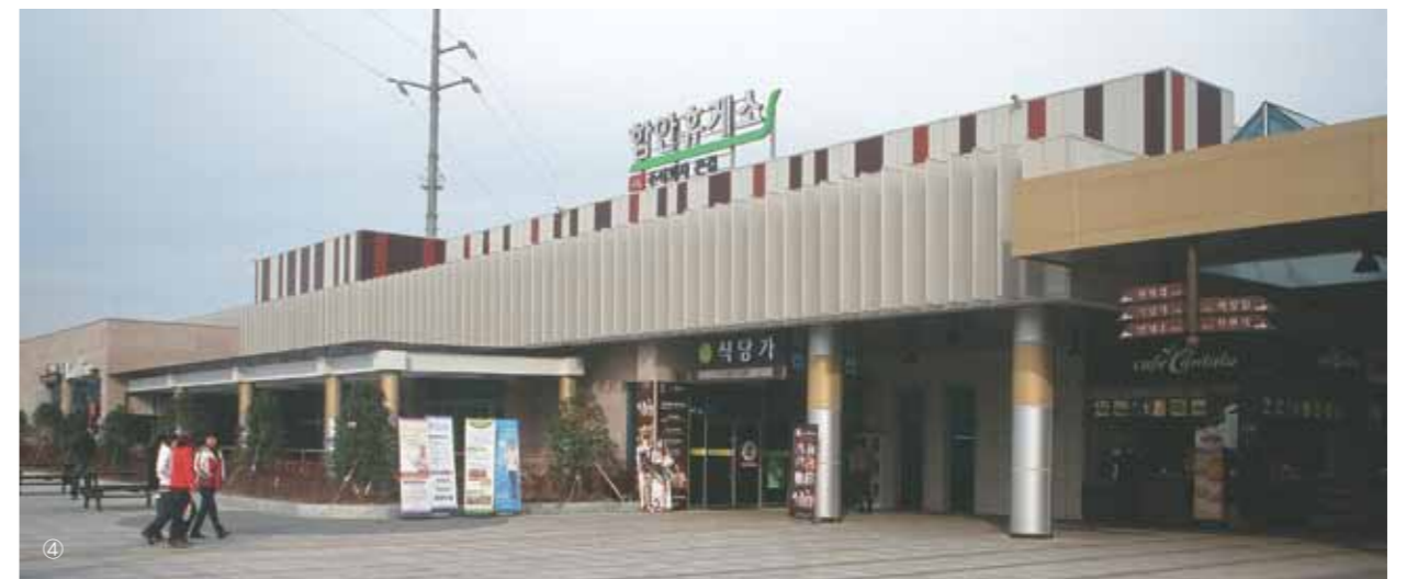
① ② • 공사명 : 함안(부산방향) 휴게소 ③ ④ • 공사명 : 함안(순천방향) 휴게소
