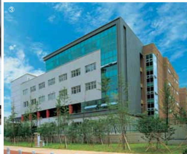
① • 공사명 : 용인 육아종합지원센터 • 위치 : 경기도 용인시 처인구 중부대로1161번길 90 • 설계 : 예가건축 ② • 공사명 : 강동 유소년 스포츠 센터 • 위치 : 서울특별시 강동구 상일로12길 60 • 설계 : G1파트너스 ③ • 공사명 : 김포 장기초등학교 • 위치 : 경기도 김포시 장기동 174-1 • 설계 : JAPA 건축
